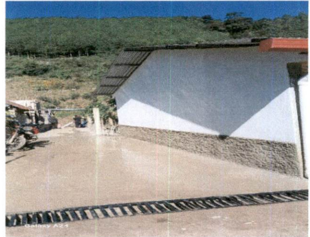
Foto 2: Finalización del mejoramiento de la losa de patio e instalación de la rejilla metálica en el área de recreación de los estudiantes.
