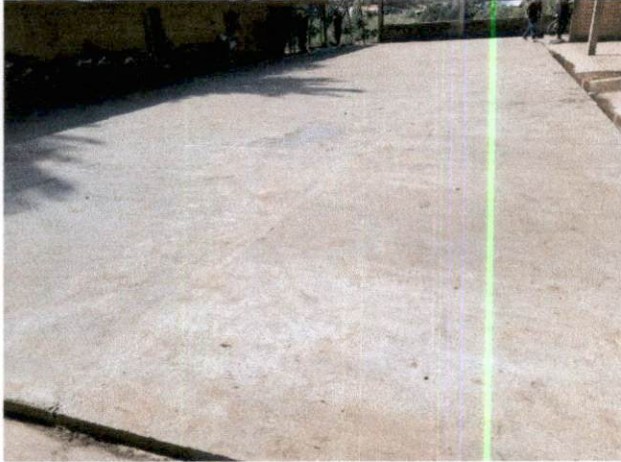
Foto 1: Finalización del mejoramiento de losa de patio en el área de recreación de los estudiantes.
