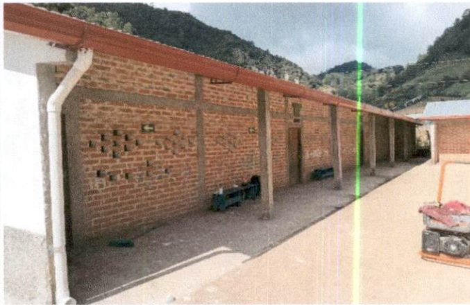
Foto 3: Canales y bajadas pluviales instaladas en el establecimiento.
